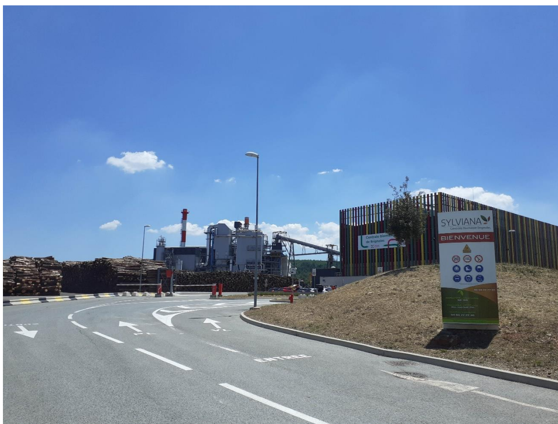
Vue de l'ensemble de l'installation : parc de stockage des billons, chaudière et hangar à plaquettes
